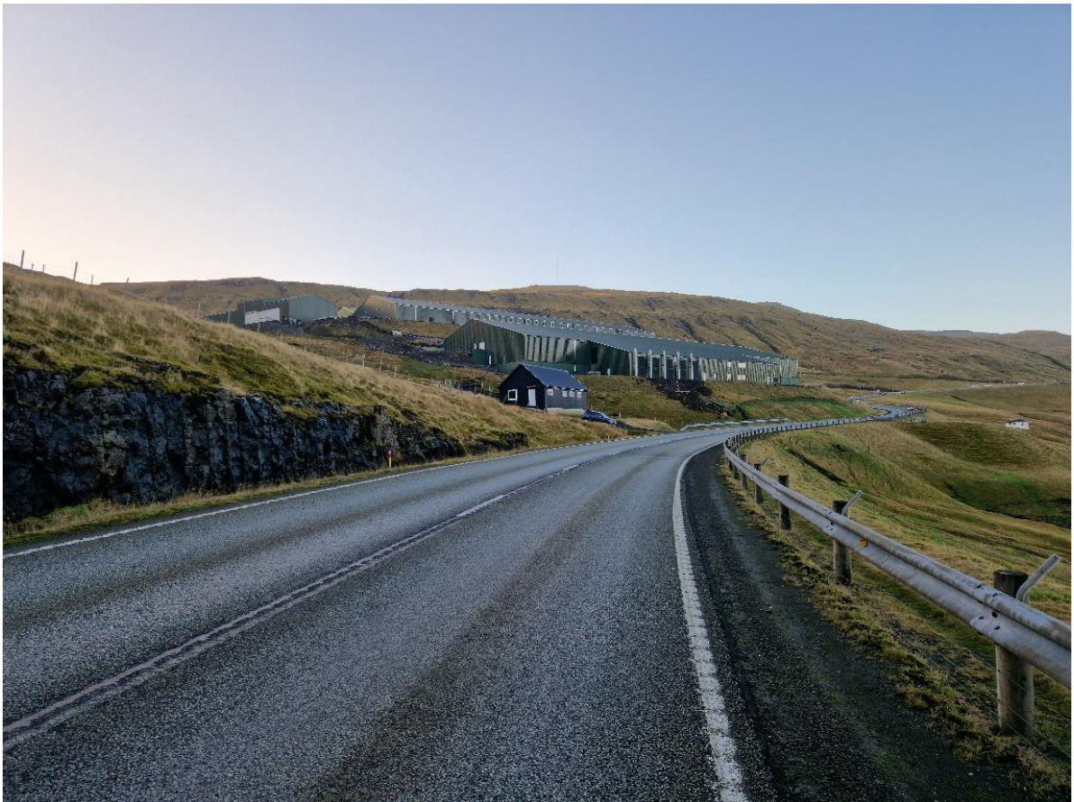
Mynd 6: Útsýni av landsvegnum eystan fyri smoltstöðina.
