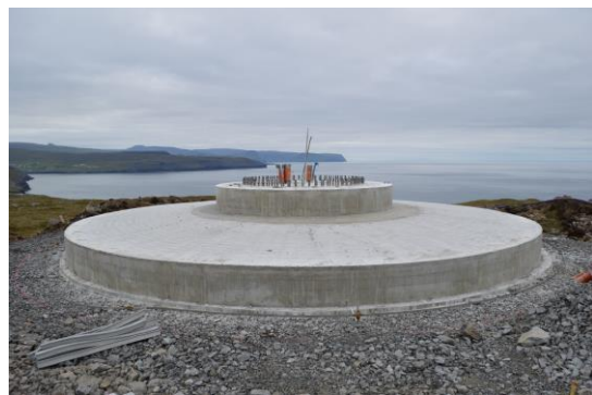
Mynd 5 Stoypt gravitáiónsfundament
