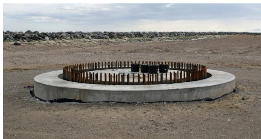
Mynd 7 Fundament tyrvd og fjald
