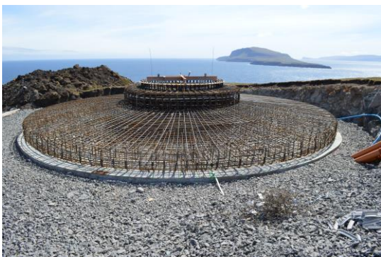
Mynd 4 Gravitáiónsfundament klárt at stoypa
