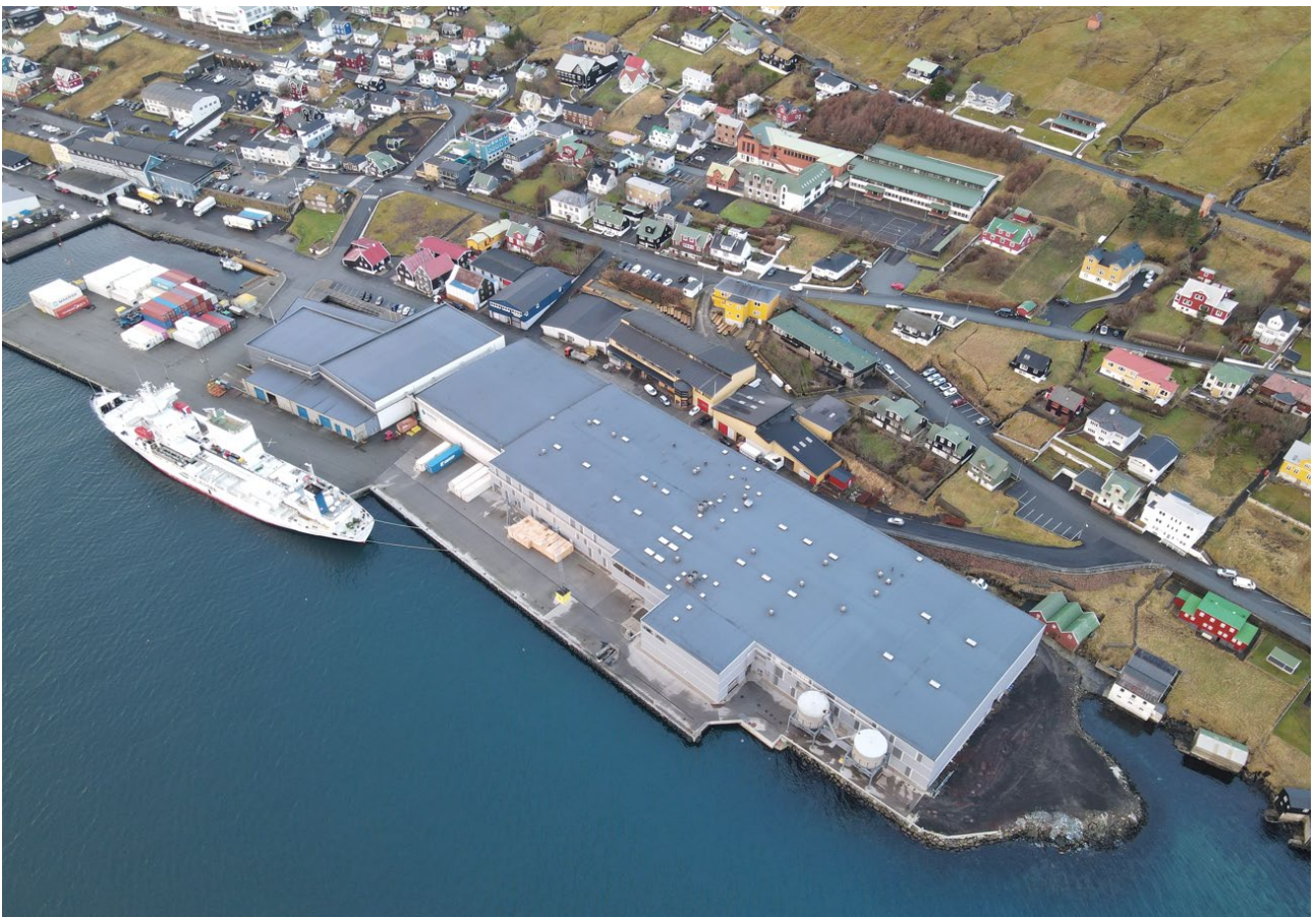
Mynd 13 Virkið við framleiðslu, frystigoyslu, avskiping og skrivstovu. Eitt flutningsskip (frystiskip) til lidna vøru sæst á myndini og tangar til rest-rávøru longst til høggru frammanfyri virkisbygningin
